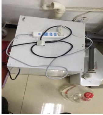
图9 污水处理设备照片
